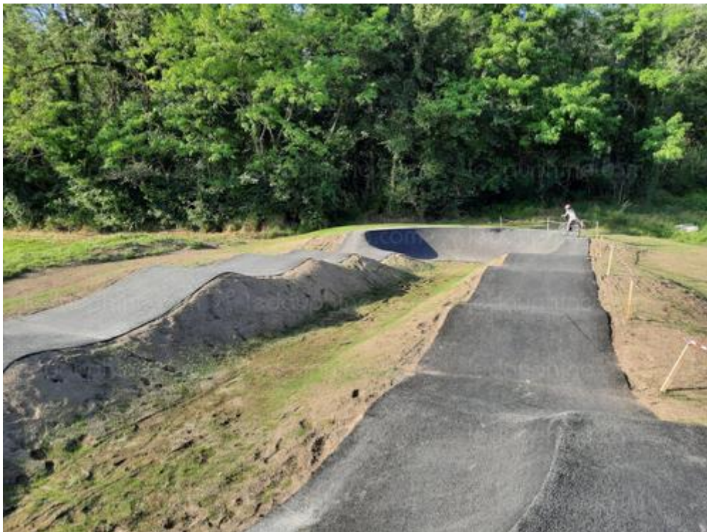
Le pumptrack s'est ajouté au projet initial.
