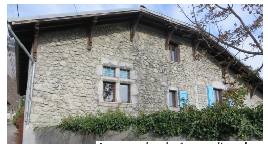
Amorce de chaînage d'angle
