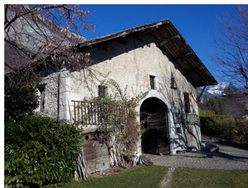
Habitat agricole initial, modeste, intégré dans le même volume que les locaux d'activité rurale
