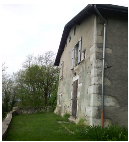
Avec chaînage vertical
