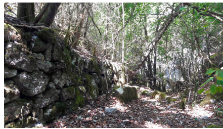
Mur de soutènement
