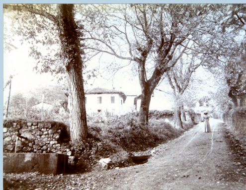
Bassin du haut de Plate-Rousset vers 1900
