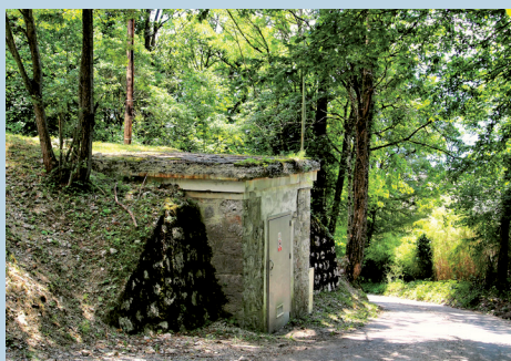
Réservoir chemin des Chevalières
