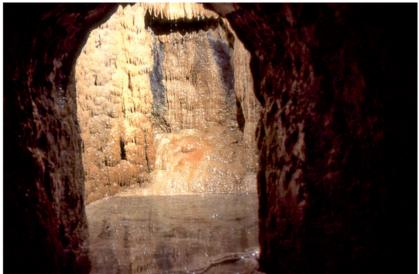
Chambre de captage
