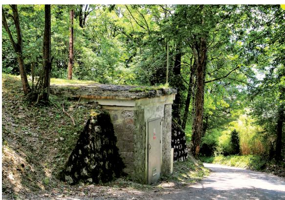
Réservoir chemin des Chevalières
