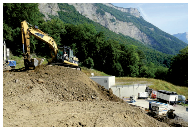
Construction du 2 e réservoir du Châtelard, 2018
