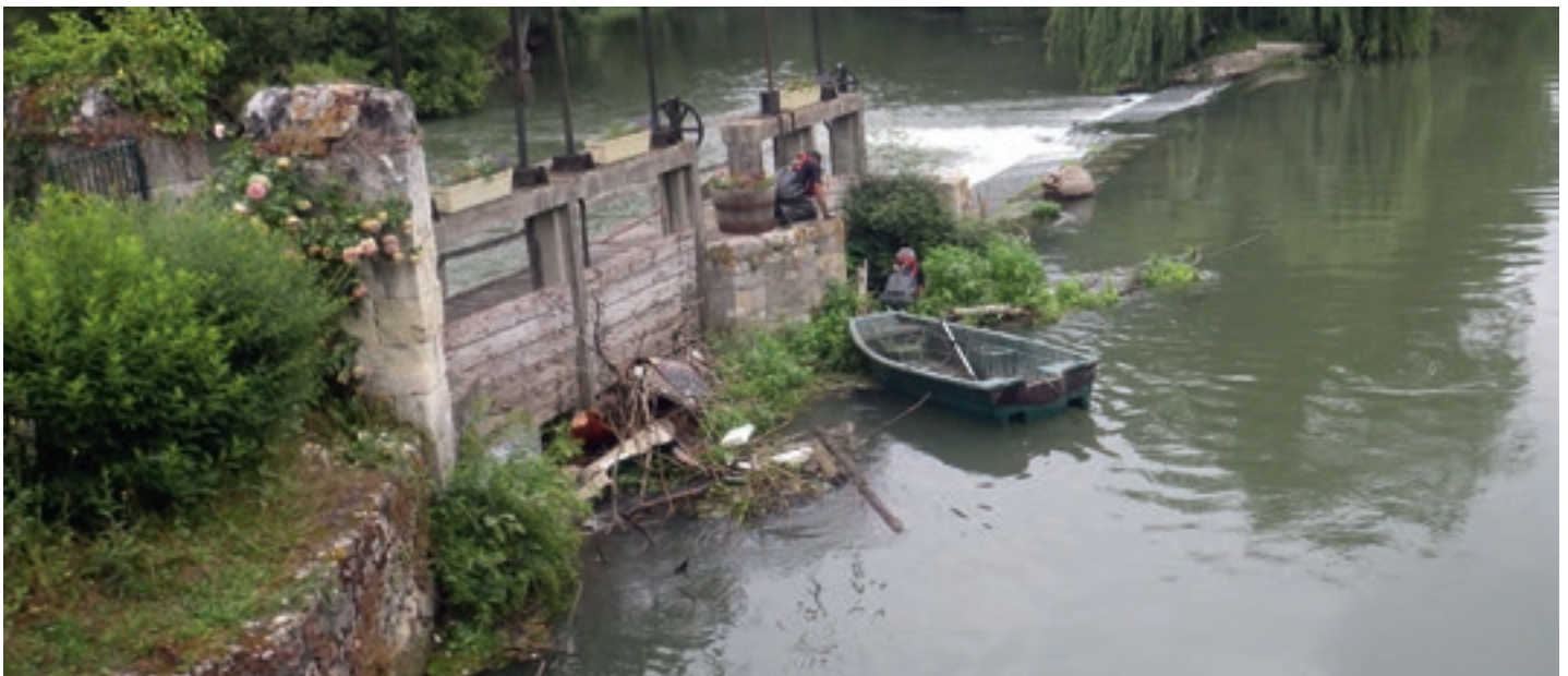
Nettoyage des vannes en juin 2018
