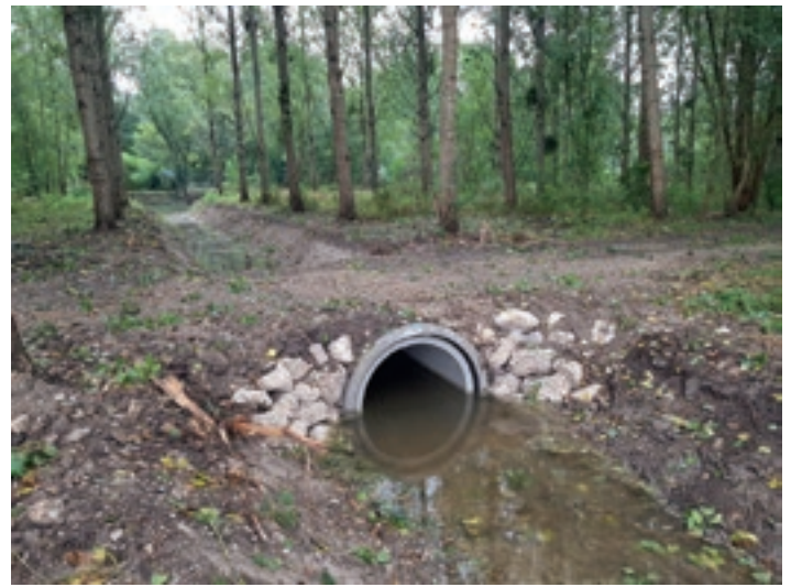
Site après intervention : reconnexion à l'Indre et remplacement de passage busé
