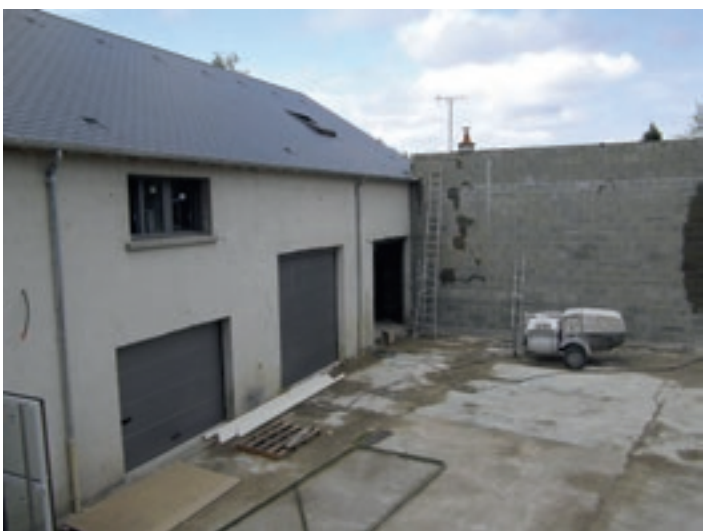
Nouveau centre technique municipal
