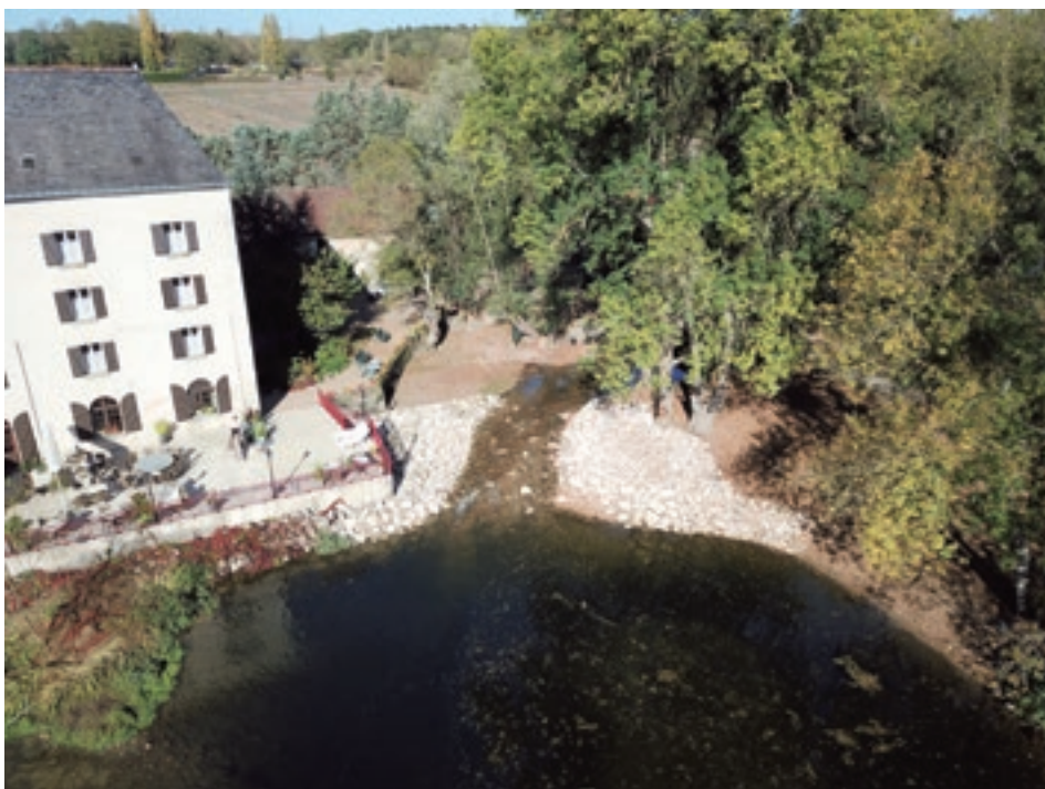
Exemple d'aménagement d'une rampe au Moulin Fleuri à Veigné
