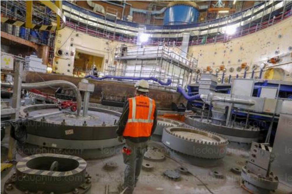
*L'exploitant, EDF, procède en ce moment au démantèlement du grand bouchon tournant. Le dernier avant l'accès à la cuve. Photo Le DL /Michel THOMAS*
