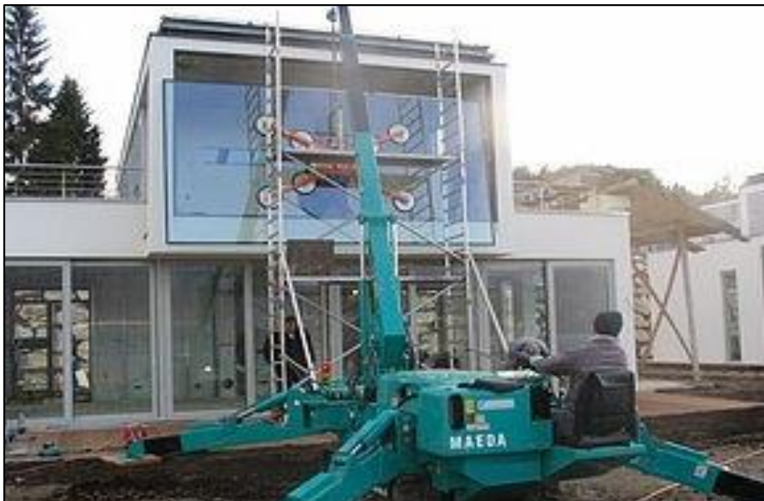
68500 ORSCHWIHR - PVC ALU+BSO EN COURS DE POSE
