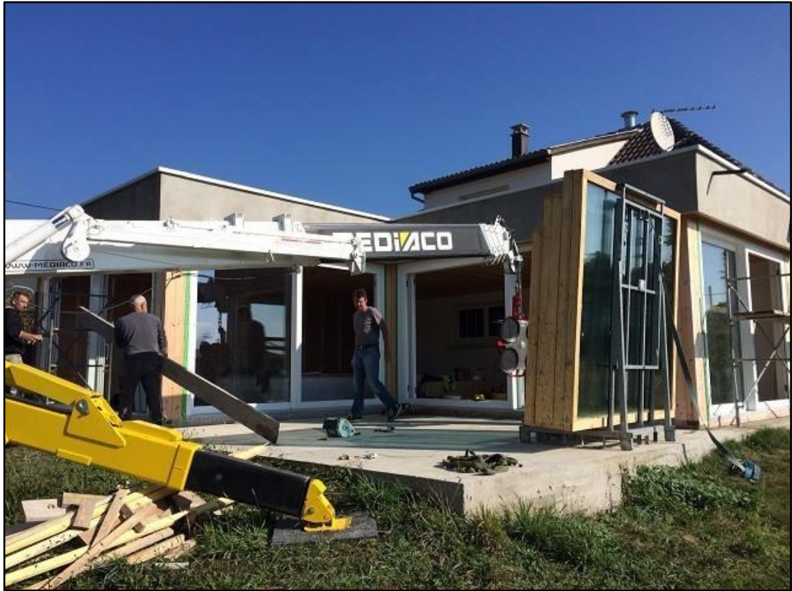
68700 CERNAY / PVC-ALU en cours de pose
