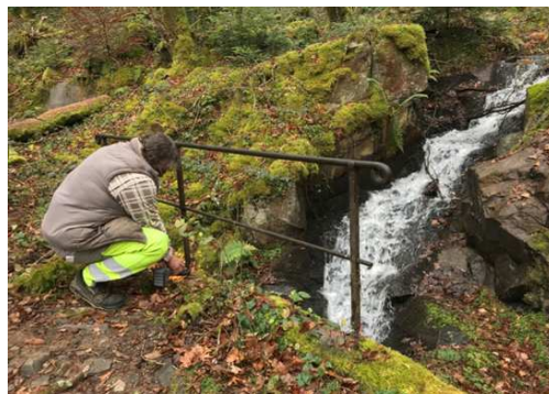
Restauration de la Rambarde de la cascade de Brocard sur le ruisseau du moulin
