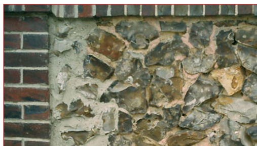
Maçonnerie de brique et silex.
