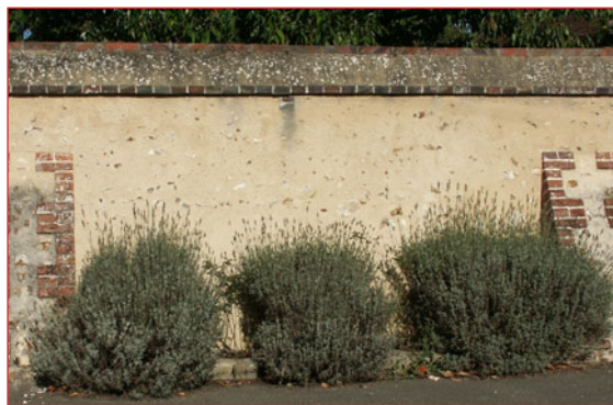
Mur de clôture en bauge avec chaperon maçonné et contreforts en brique. Escorpain
