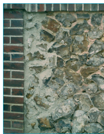
Mur en silex et chaîne en brique.
