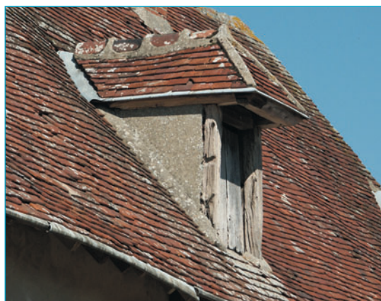
Lucarne sur le versant du toit, charpentée, et à croupe débordante.
