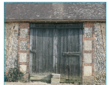
Tuiles en terre cuite, silex, bauge, briques en terre cuite, hêtre pour la porte de la grange. Saint-Jean de Rebervilliers.
