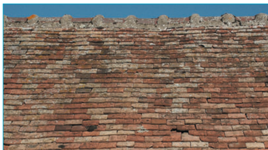
Le faitage des toitures en tuile
