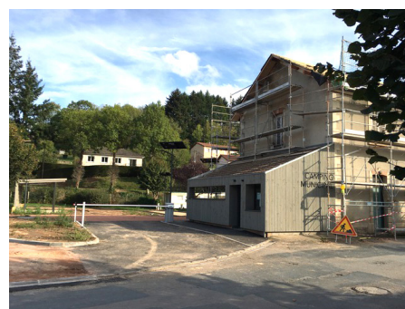
Entrée camping pendant travaux
