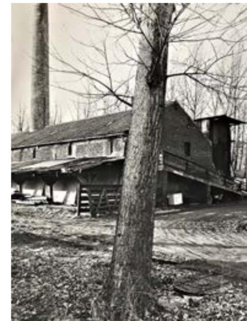
diesel. L'argile était prélevée par un excavateur à godets qui grattait l'argile. L'argile était transportée vers deux presses. Sur chacune d'elles il fallait trois personnes : un briquetier pour placer l'argile dans les moules, un autre pour récupérer les briques moulées et charger 76 briques de 2 Kg 340 sur une brouette et un 3e pour placer les briques dans les hangars de séchage. La presse tournait en continu. Objectif : 14 000 briques par jour et par presse !
