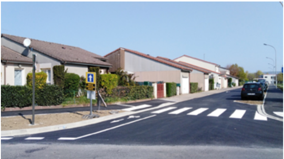
Rue Jean Mermoz après travaux.
