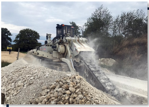
Travaux Zone d'Activité Economique
