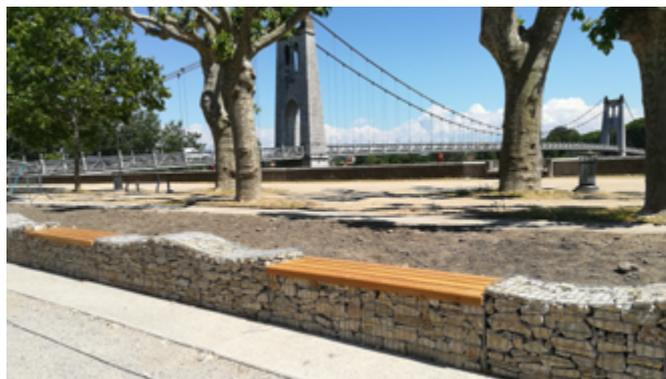
Un mur en gabion en pierre d'Eyzahut de plus de 100 mètres a été installé du côté de l'office de tourisme, le long des places Étienne Jargeat et Camille Debard. Très utilisé pour sa modernité et sa résistance, il a été recouvert de bois afin de permettre aux personnes de s'asseoir et d'avoir une vue sur notre beau château.
