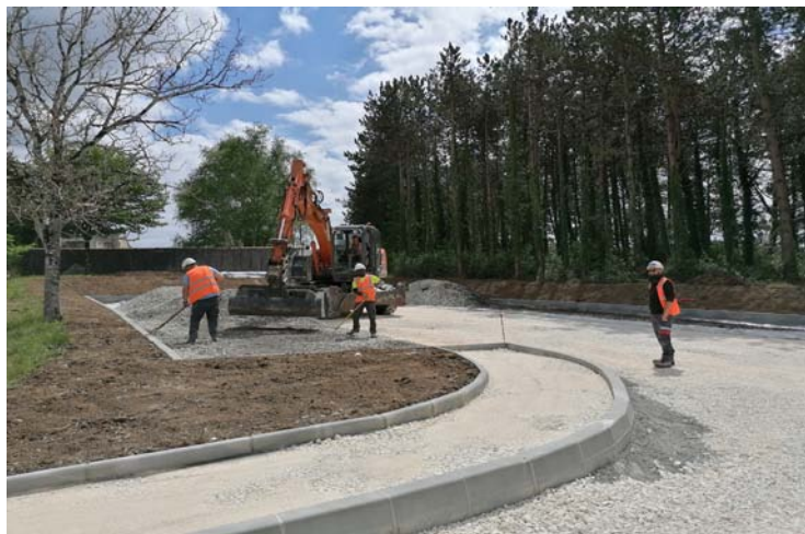
début des travaux
