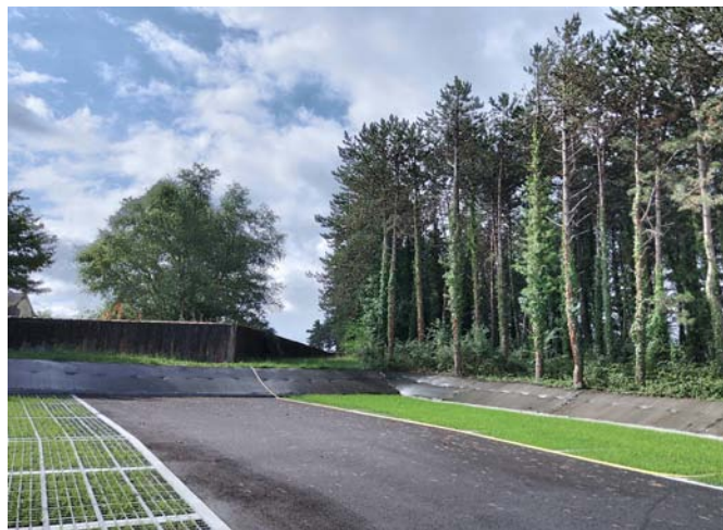
fin du chantier
