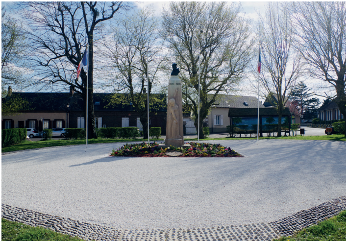
« Rénovation du sol du monument aux Morts » Rue Jean Jaurès
