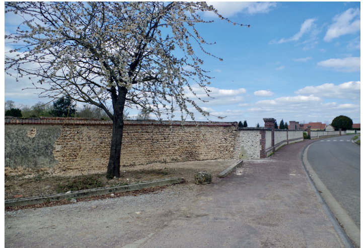
« Réfection du mur du cimetière » Rue de Foucrainville
