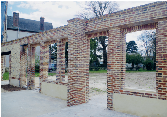
« Réfection du mur du site Bernard » Rue de Dreux
