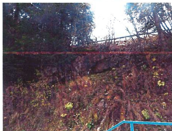
Talus vertical rocheux* à l'est de la zone
