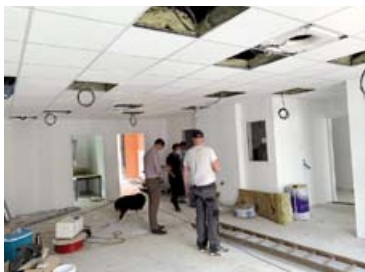
Les travaux de la Maison médicale en juin.
