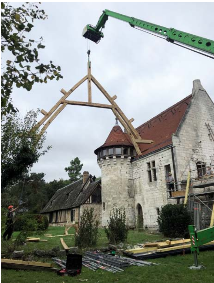
Les travaux récents de restauration du pressoir incendié.
