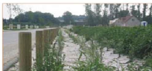
Une noue collectrice des eaux pluviales.
