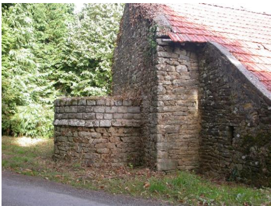
le Gardef (en restauration)
