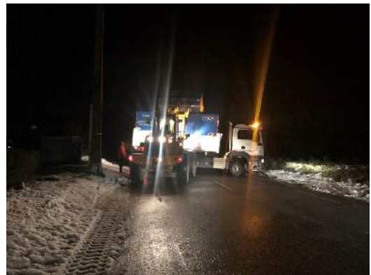
Mise en place d'un générateur à La Molle
