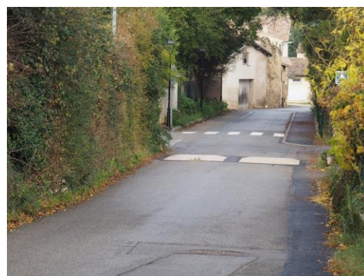
Création d'un trottoir et pose de coussins berlinois Route de la Baume
