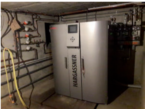
Figure 1 - remplacement de chaudière
