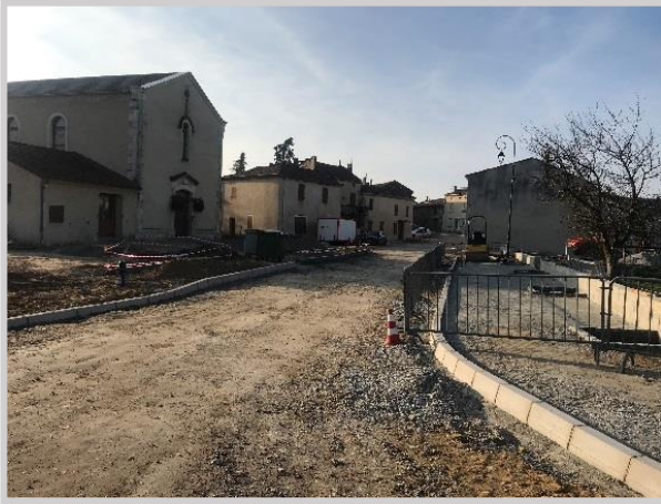
Travaux au cœur du village
