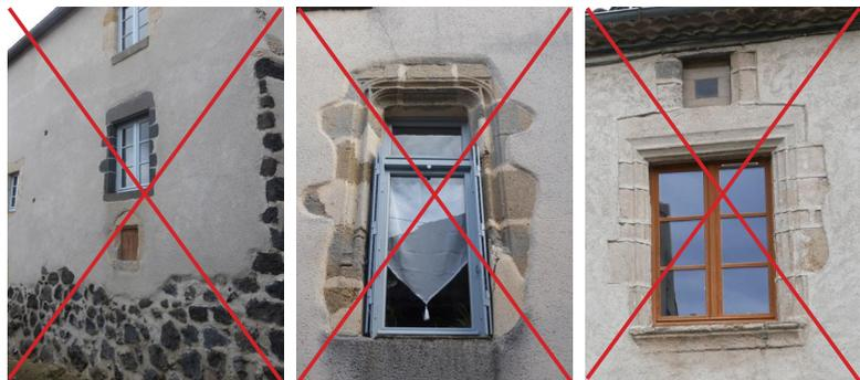
Les enduits doivent couvrir toute la façade (1) et ne doivent pas être en surépaisseur vis-à-vis des éléments en pierre de taille (2). Les joints ne doivent pas être tirés au fer.
