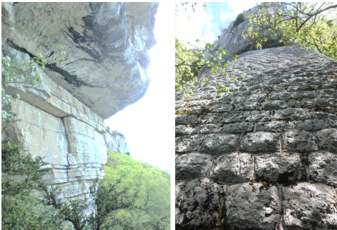
Figure 4 : clichés au niveau du Roc de Torméry (à gauche surplomb, à droite buton maçonné) (RTM, 2016)
