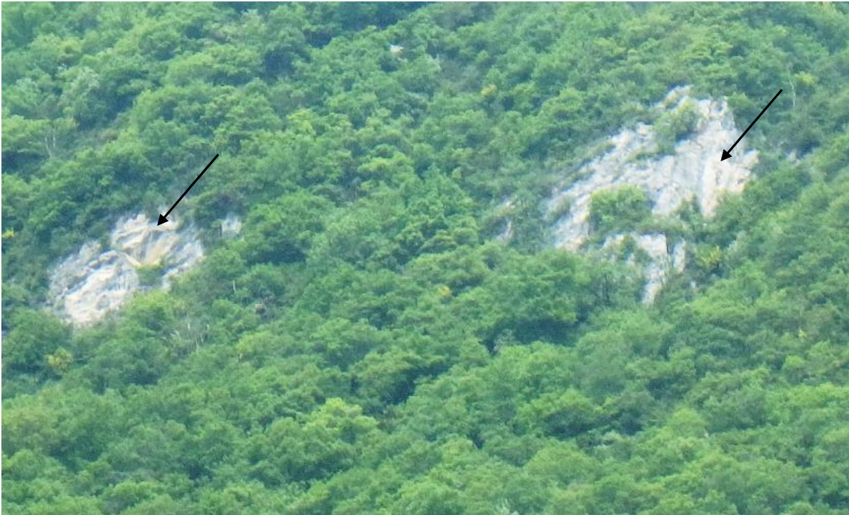
Figure 18 : Traces de cicatrices sur les affleurements en amont de Viviers (RTM, 2016)
