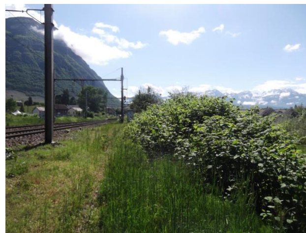
Massif de Renouée du Japon proche de la voie ferrée-Epode 6 mai 2015
