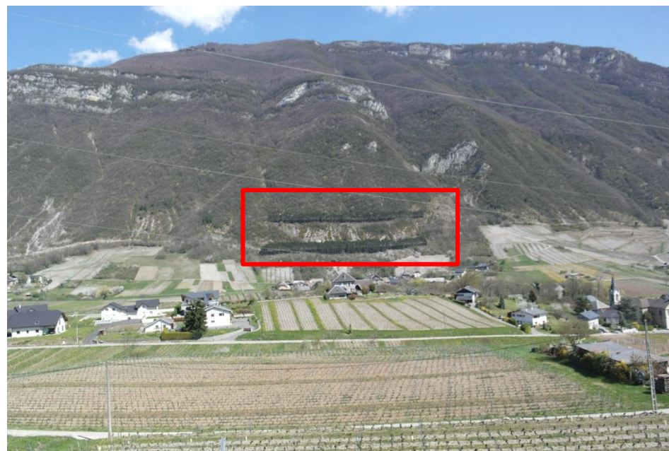
Protection contre les rochers sur le coteau au dessus du Viviers, vignobles en bas de pente et forêt sur les hauteurs
