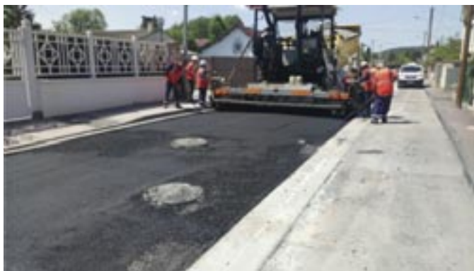
Grave bitume en cours d'application
