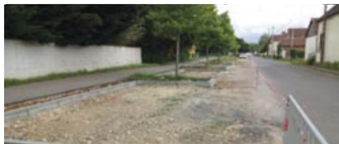
Les places de stationnement en cours d'aménagement
