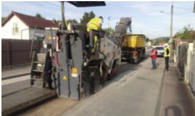
Phase de rabottage de la chaussée existante
