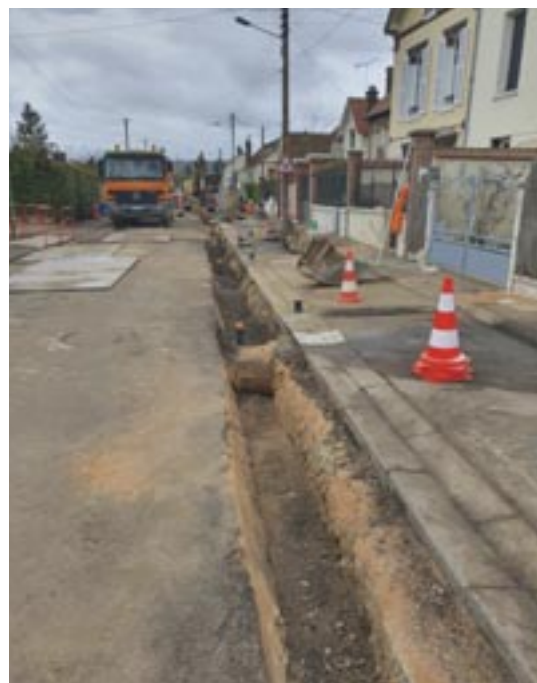
Pose de la canalisation principale d'eau potable
