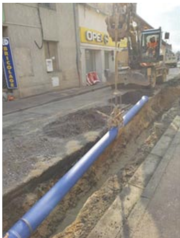
Pose de la canalisation principale d'eau potable
