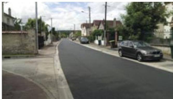
Après application de la couche de roulement
