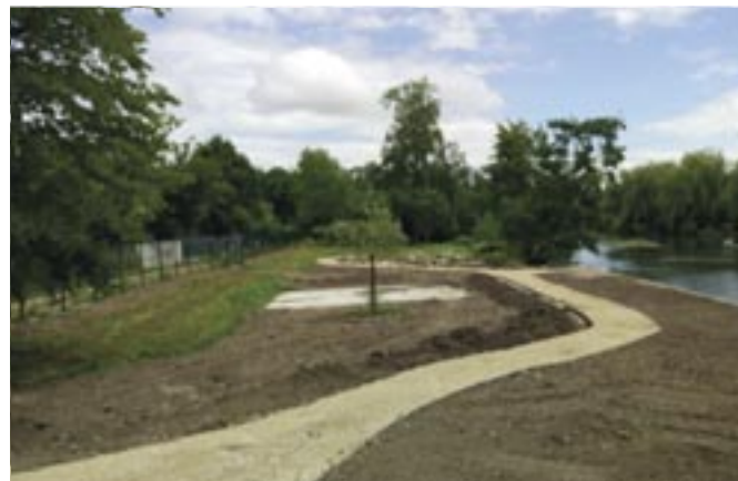
Le parc paysagé de la passerelle en cours d'aménagement
