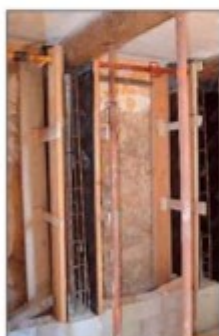
► Le renforcement du plancher.
