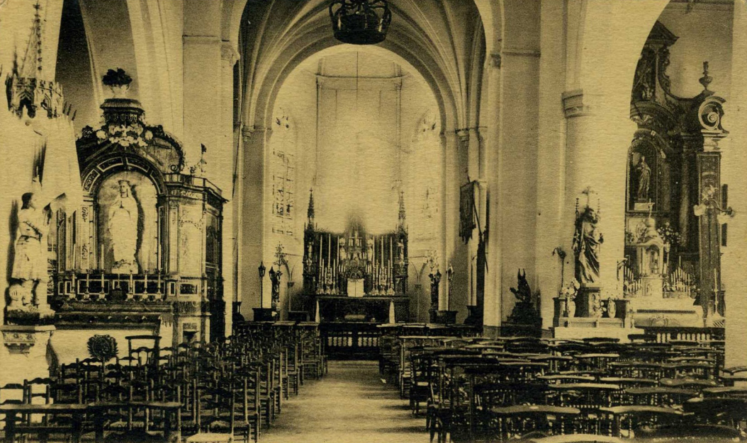
L.P. 7 - ZEGGERS-CAPPEL - Nord - Intérieur de l'Eglise
