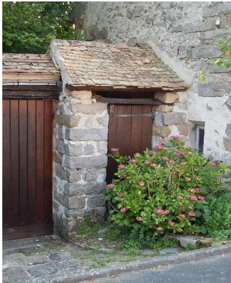
Situé dans une cour commune ce puits est surmonté d'une maçonnerie de plan carré. Il est clos par une porte en bois et couvert d'une toiture à deux versants en tuiles plates.
