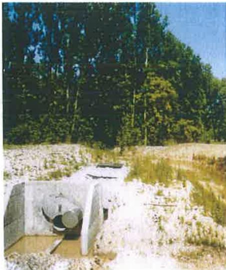
➡ Travaux de mise en oeuvre des dispositifs de traitement (sur la partie ouest) des eaux pluviales ; rejet en direction de la zone humide aval
