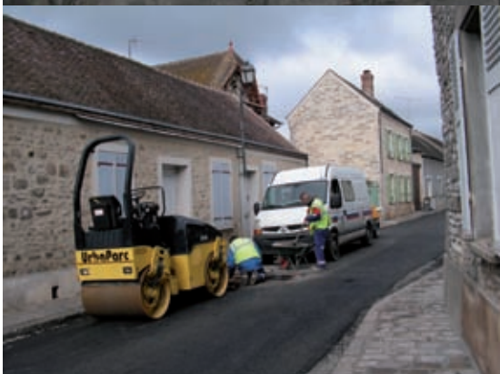
Travaux de réfection de la chaussée de la Grande Rue en avril 2012
