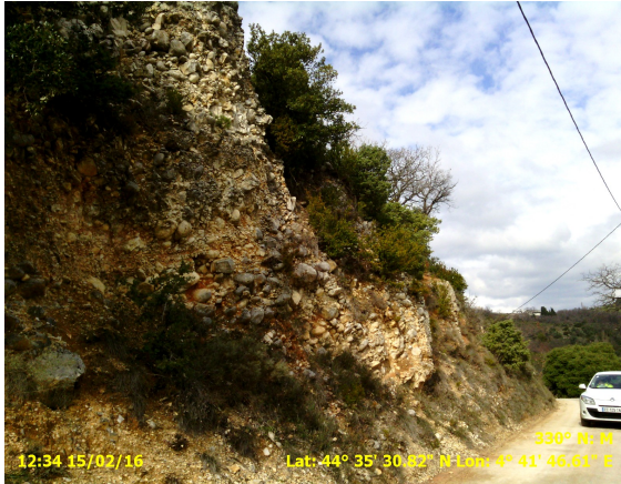
Illustration 12 : Blocs susceptibles de se déchausser d'une falaise conglomératique
