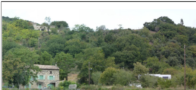
Illustration 56 : Versant exposé aux chutes de blocs et glissements de terrain
