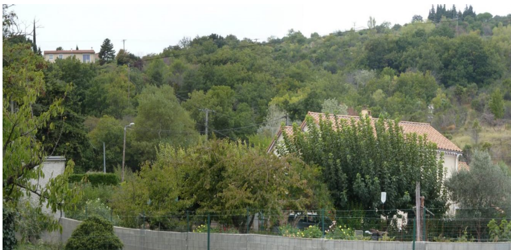
Illustration 30 : Vue sur le versant de pente forte (G3) et la partie basse des lotissements (G1)
