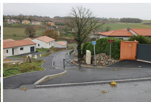
Création d'un trottoir avant le rond point de la Gauzide
