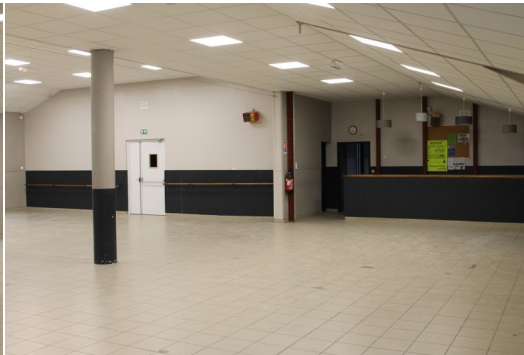
11 décembre 2019 : Fin des travaux du plafond de la salle des fêtes endommagé par de fortes rafales de vent début mars. Renforcement de la charpente, réfection de l'électricité. Pose porte des WC et grande baie vitrée en accès terrasse.
