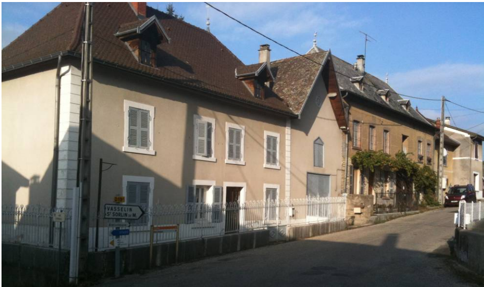
Bourg-centre, rue de la Rochetière
