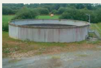
Silo à boues
