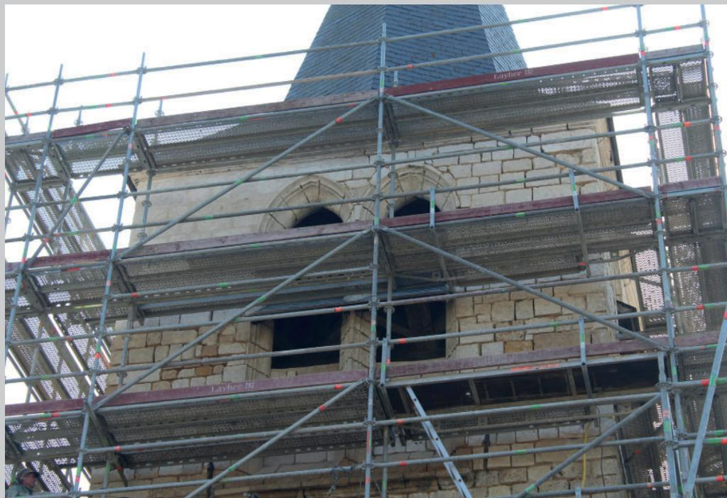
Les travaux de l'église sont toujours en cours. Le décapage a été réalisé et maintenant les pierres endommagées ont été remplacées et les jointoiements sont en cours de rénovation.
