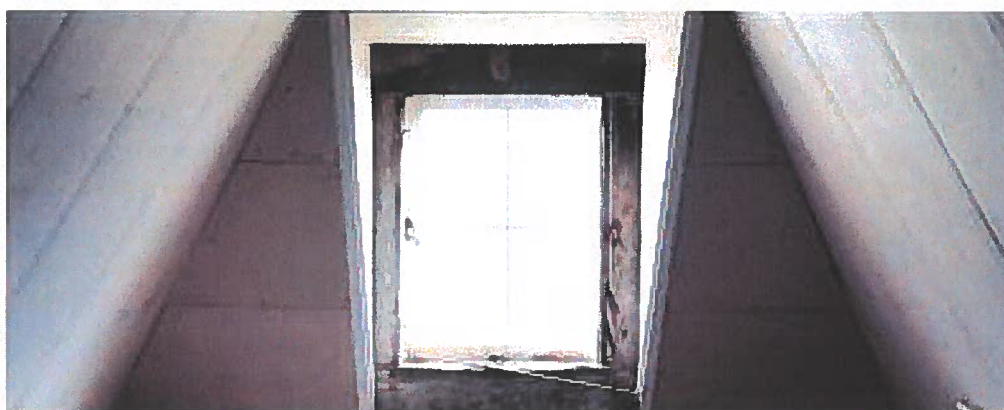
Combles à isoler
