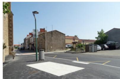
Ils ont permis la création d'un équipement plus sécurisant pour les usagers des transports en commun. Le rehaussement de la chaussée permet que le bus soit à hauteur du trottoir, facilitant ainsi la montée dans le transport et le rendant accessible aux personnes à mobilité réduite. Le bord du trottoir « marbré » évite également les usures sur les roues des cars.
