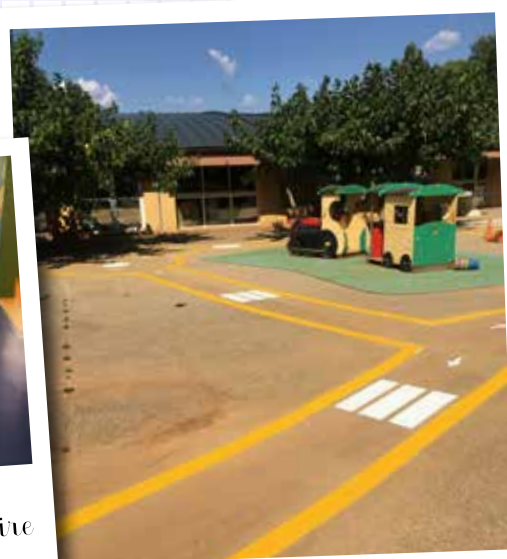
Réfection des peintures au sol
