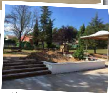
Construction d'un muret
