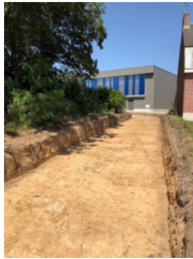
préparation de la voirie autour de la salle de sports
