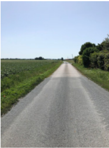
Travaux rue du 5 septembre 1944
