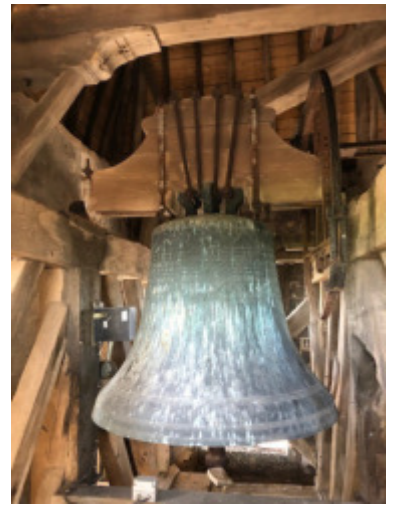
remise en état des brides des cloches de l'église
