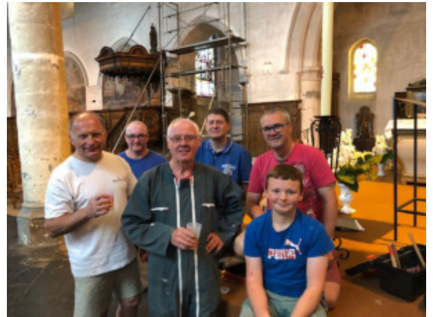
installation de la nouvelle sonorisation à l'église par les bénévoles
