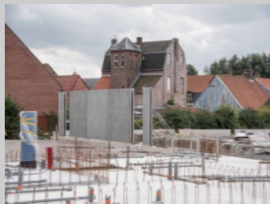
SEPTEMBRE 2018 : LES PREMIERS MURS
