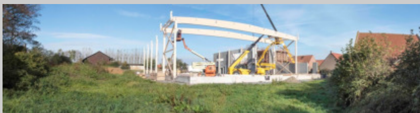
OCTOBRE 2018 : MONTAGE DE LA CHARPENTE
