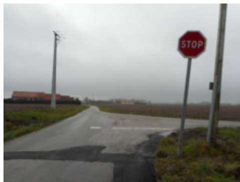
Rue du 5 Septembre Pose de Stop
