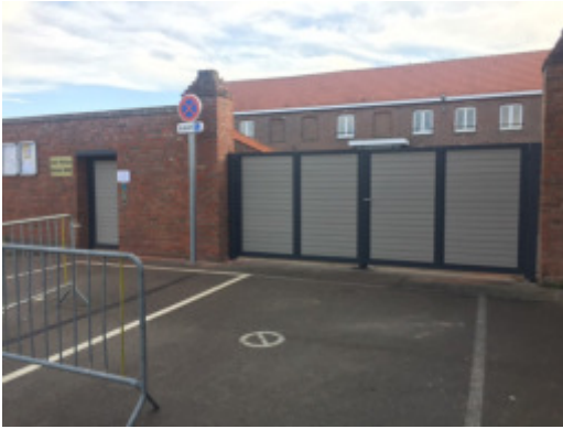
Ecole Portail électrique
