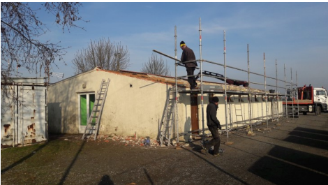
Rénovation toiture vestiaires Foot
