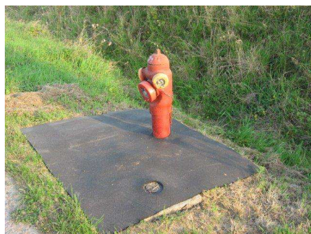
Pose de tapis par Noréade autour des bornes incendie
