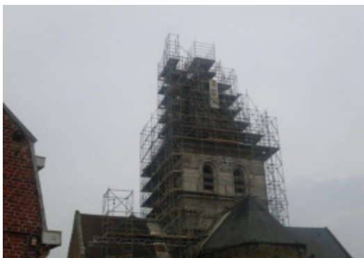
pendant les travaux
