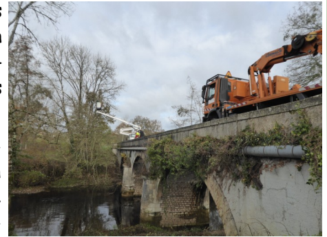
Nettoyage et élagage au pont de Cherveix
