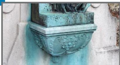
Elle transporte les produits de corrosion des métaux et provoque l'apparition de **taches**.
