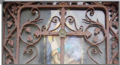
**Les métaux** : essentiellement les ferreux (fer forgé, fonte), les cuivreux (bronze et laiton) et parfois le plomb pour les scellements.
