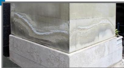
Elle transporte les sels minéraux dans les pores de la pierre, puis les dépose sous forme d'**efflorescences** lorsqu'elle s'évapore.
